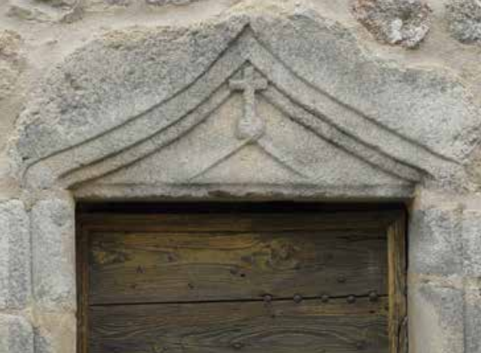
Linéau de porte en accolade (XVe siècle) sculpté en son centre d'une sphère surmontée d'une croix symbolisant le peuple chrétien assemblé
