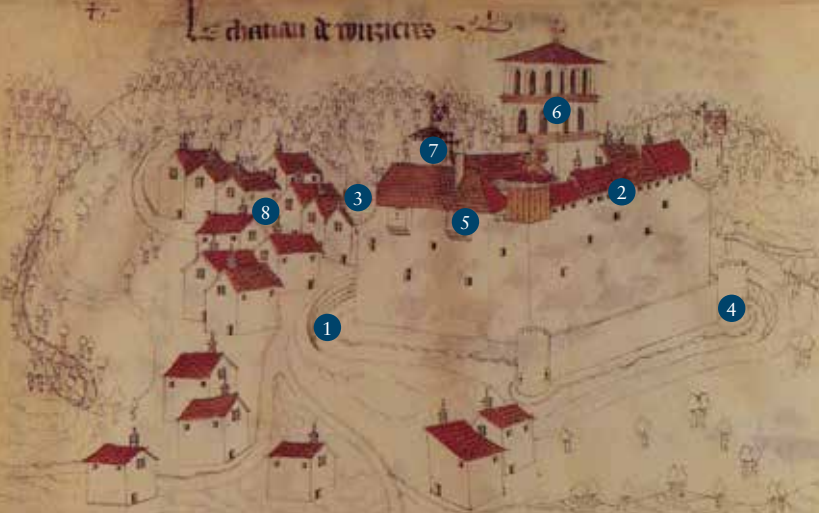
Vue cavalière de Rozier-Côtes-d'Aurec. Armorial de Revel. 1450 (Bibliothèque nationale de France)
